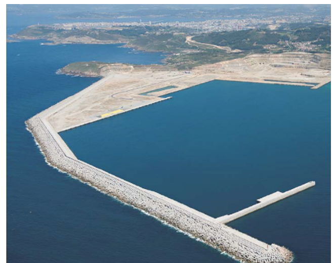
Fig: The 3.200 meter long seawall
